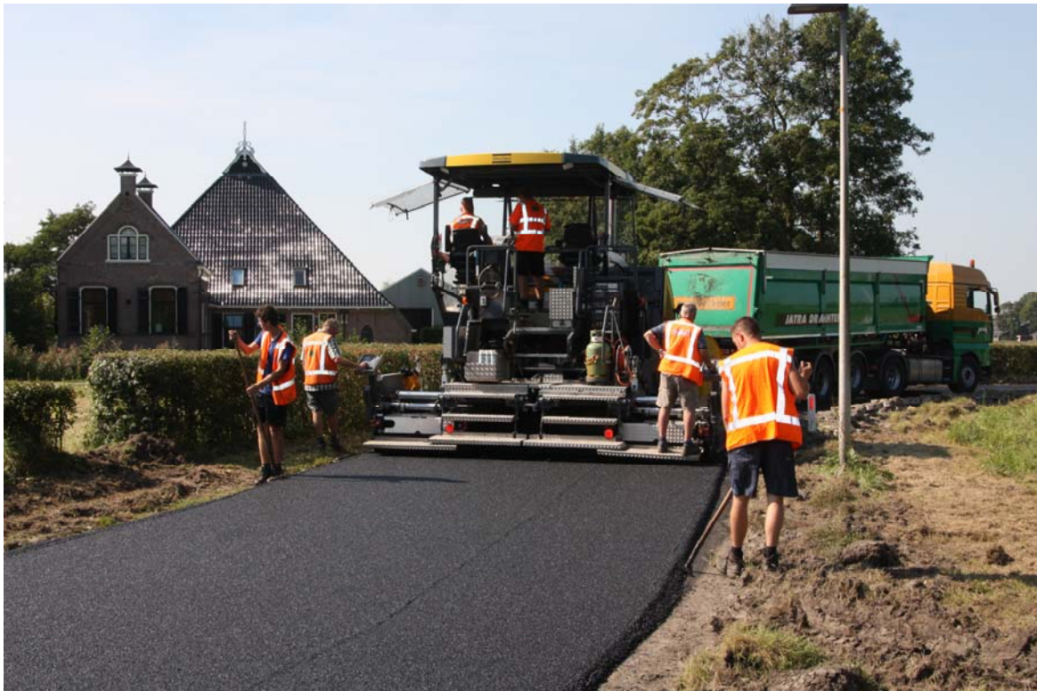
Afbeelding 1: Op 15 september 2016 werd tussen Leeuwarden en Stiens een fietspad aangelegd met asfalt waarin cellulose uit afvalwater is verwerkt: "Een wereldprimeur!" (met dank aan Wetterskip Fryslân)
