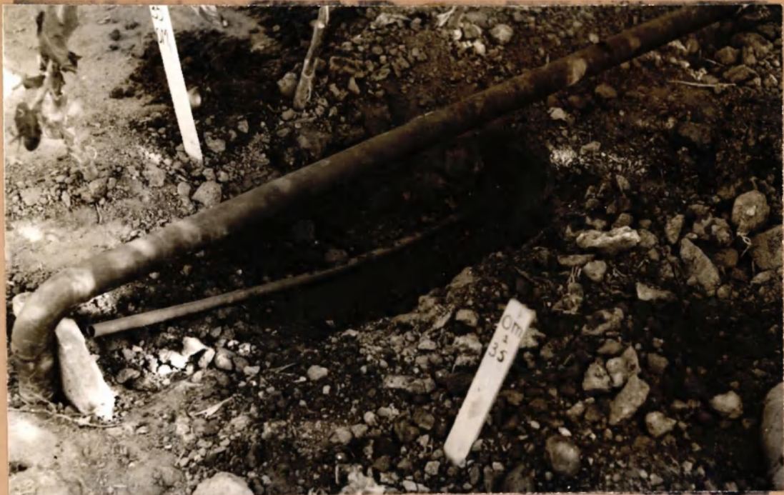
fig.1 Een infiltratiebuis ingegraven tussen twee rijen tomaten
