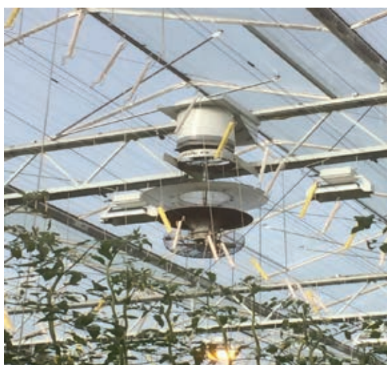
Figuur 1 Het Ventilation Jet systeem bij Greenco (links), ook wel de brievenbus variant genoemd. Het Ventilation Jet systeem bij Gardener's Pride (rechts), hier lopen de schermen boven en door de koker heen. Deze schermen hebben gaten waar de lucht doorheen kan stromen.
