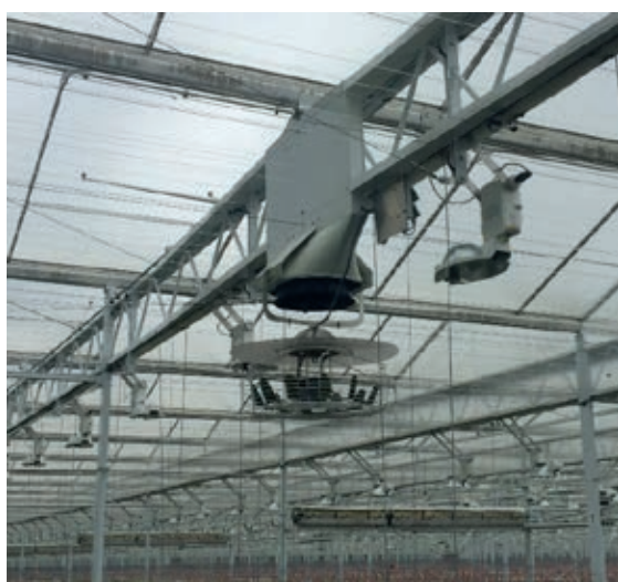
Figuur 1 Het Ventilation Jet systeem bij Greenco (links), ook wel de brievenbus variant genoemd. Het Ventilation Jet systeem bij Gardener's Pride (rechts), hier lopen de schermen boven en door de koker heen. Deze schermen hebben gaten waar de lucht doorheen kan stromen.
