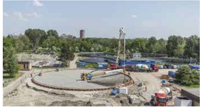
Werkzaamheden op de zuiveringsinstallatie in Leiden
