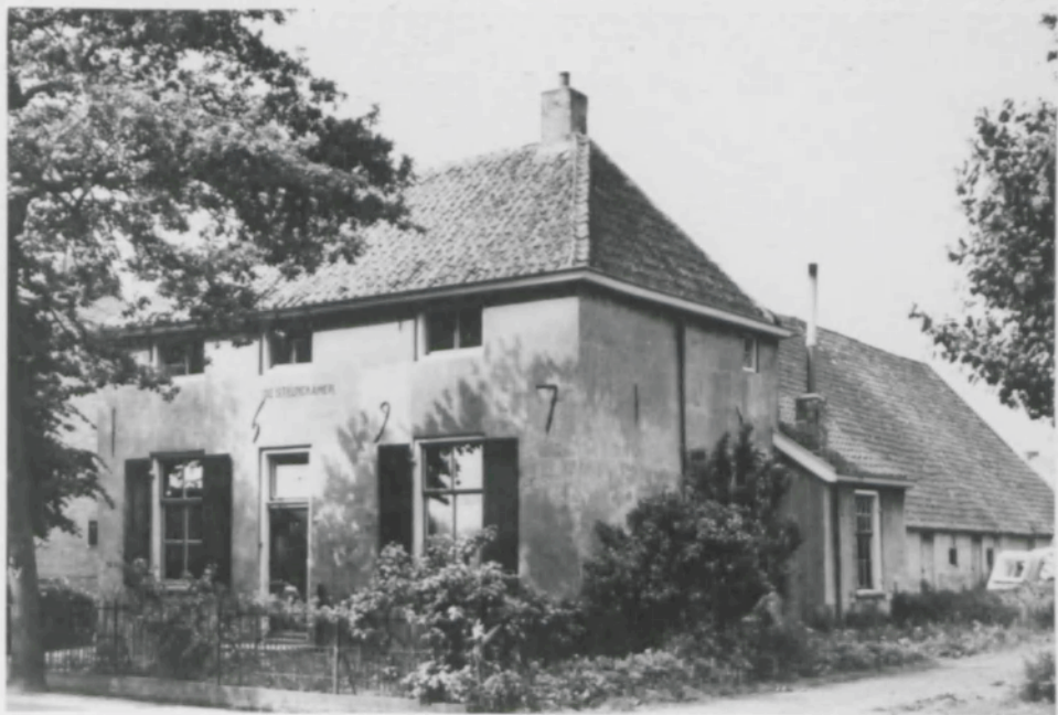
6. "De Steene Kamer" bij de Dolderbrink met het jaartal 1597? in de muurankers.
