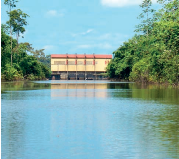
Afbeelding 3. Corantijnkanaal met het gemaal Wakay
