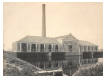
Foto: Gemaal in Spaarndam
