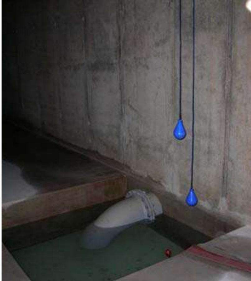
Figuur 12 Zuigkuil met niveaumetingen.
