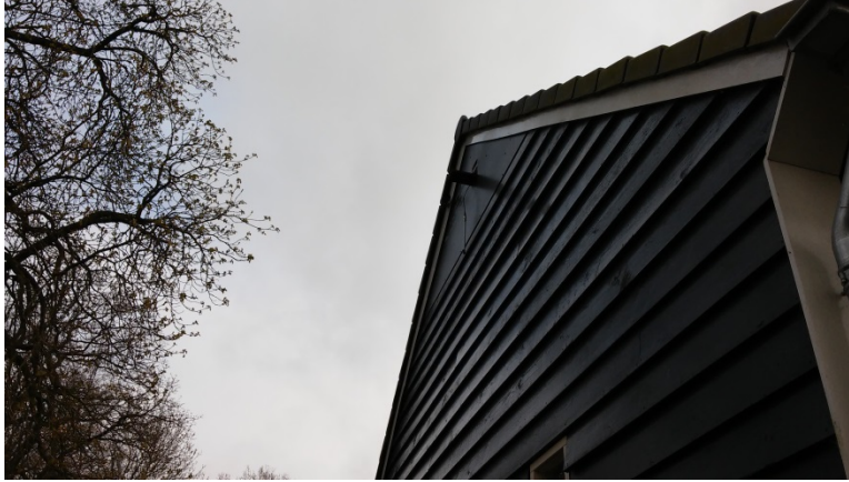
Figuur 10 LoRa-antenne hangt uit de "uileningang".
