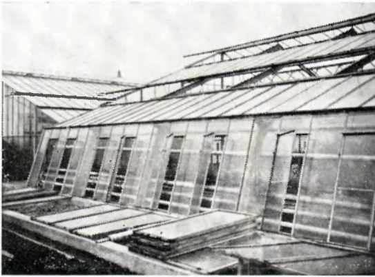
Afb. 5. Anjerkas met vele luchttingsmogelijkheden: doorlopende, twee meter brede nok- en dakluchting en verticale klappramen in zijgevels
