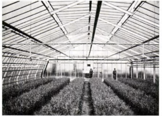
Afb. 2. Interieur van de kas van afbeelding 1; gehard glas en verzinkte onderbouw
