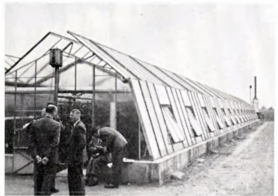
Afb. 6. Kascomplex met elektrisch aangedreven dakluchting waarbij het gehele dakvlak om de goot draait (tandstangmechaniek). Tuimelramen in de zijgevels
