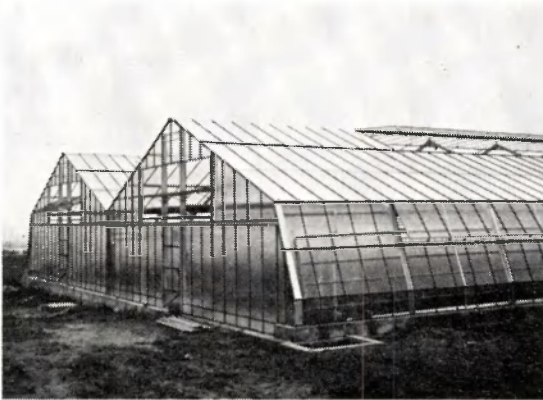
Afb. 1. Eindgevel van een moderne kas (2 kappen van 12 \times 150 m) met doorlopende nok- en zijluchtingen
