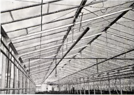
Afb. 3. Kas met elektrisch aangedreven doorlopende nokluchting (2 m breed) in aanbouw. De luchtramen zijn tegen schranken geschoord
