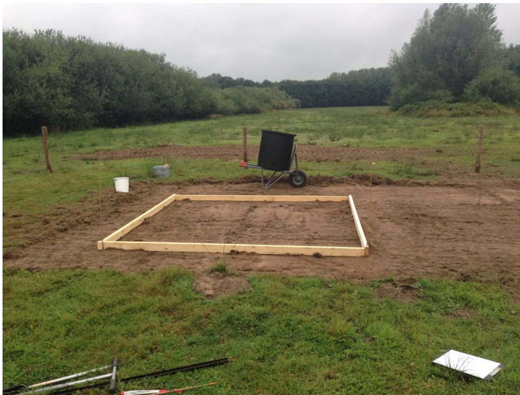
FIGUUR 3-5. VOORBEELD VAN DE BEKISTING, HIER IN DE SCHEEKEN.
