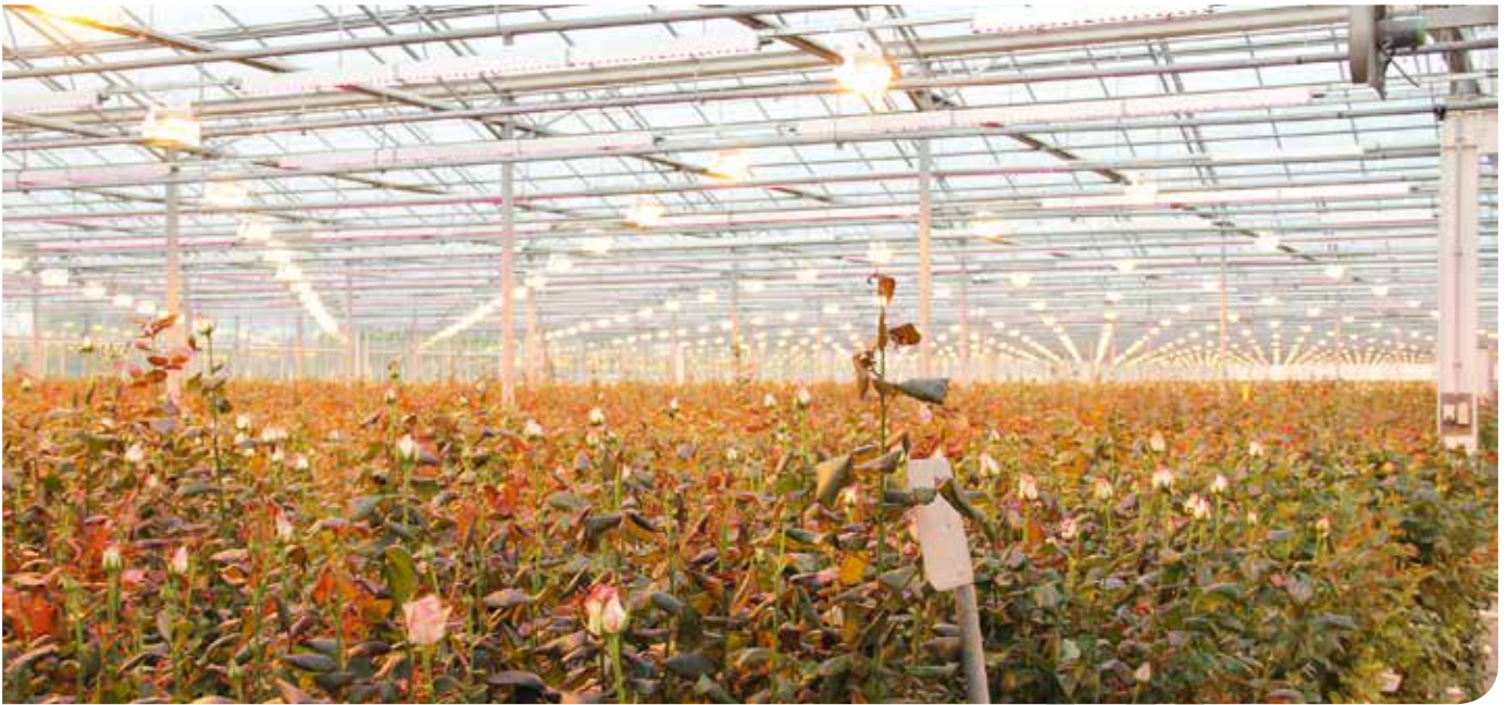
▲ Op plantniveau zorgt de LED-belichting voor 90 \mu\text{mol}/\text{m}^2\cdot\text{s} licht en de hogedruknatriumlampen voor eenzelfde lichtniveau (bedrijf Wimceco)
