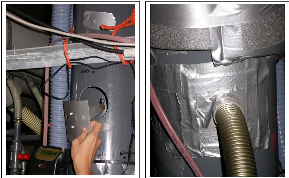
Figuur 5.8 Aftapluik voor het nemen van luchtmonsters vóór de biowasser.
