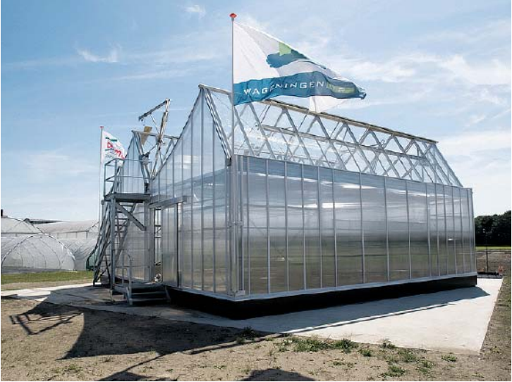
De kas kan draaien om de optimale zonnehoek te zoeken.
