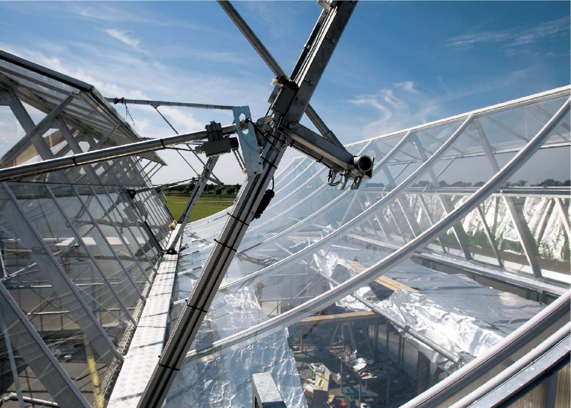
De dakconstructie van de Elkas in aanbouw. Het gebogen glas laat het zichtbare licht door maar reflecteert de zonnewarmte naar zonnepanelen. Foto’s Leo van Velzen
