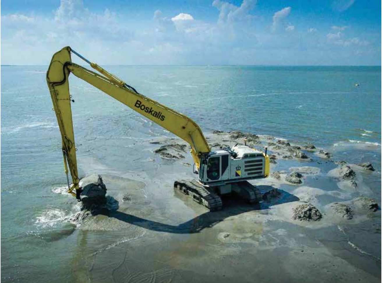
Boskalis legt de Marker Wadden stap voor stap aan. Eerst een onderwaterdam en vervolgens ringdijken
