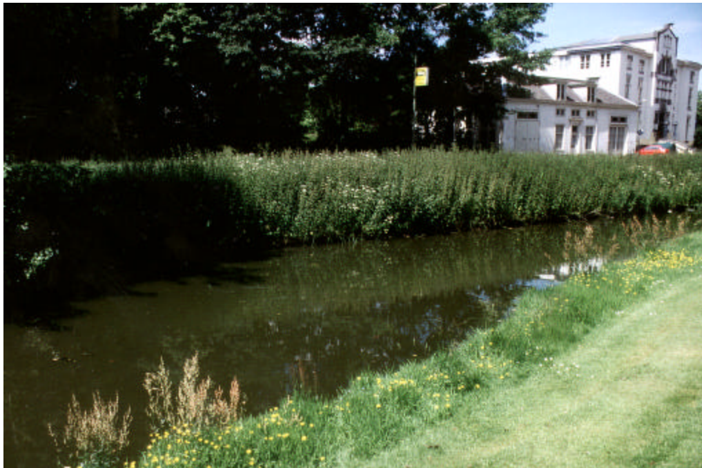
Fig. 9 Buitenplaats Hoog Beek & Royen; opoffering van de overplaats aan het wegverkeer zal de natuurkwaliteit van de omgeving negatief beïnvloeden.
