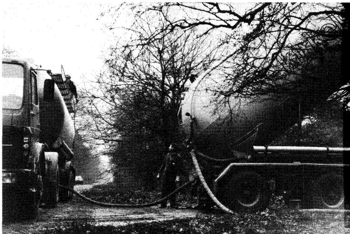
Foto 11. De silowagen wordt op de werkplek bijgevuld
