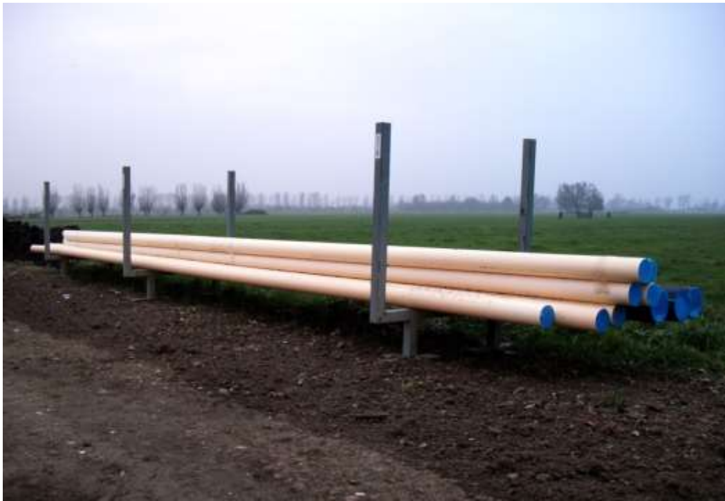
Figuur 3 De wijze van opslag van buizen op werklocaties.
