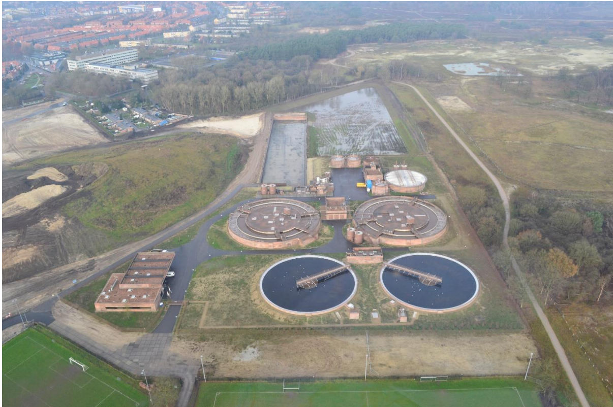
Afbeelding 1. Voorbeeld-rwzi Hilversum: conventioneel mUCT-systeem (twee straten met facultatieve tank)
