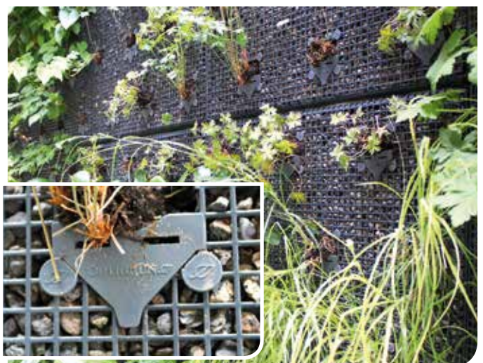
De modules van Optigreen zijn opgebouwd uit traliewerk van gecoat aluminium gevuld met lavasubstraat
