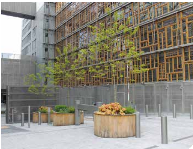
De gevel van dit nieuwe Europegebouw is een patchwork van houten raamkozijnen die gerecupereerd zijn bij renovatie- of sloopwerkzaamheden in alle EU-lidstaten
