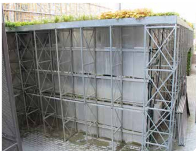
Een losstaande nieuwe metalen structuur werd speciaal opgebouwd voor het bevestigen van de groene wand
