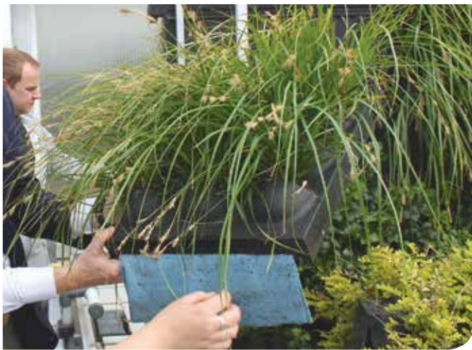
Deze cassettes worden in het gootprofiel bevestigd zodat de beplanting door middel van de capillaire werking van een doek wordt voorzien van water en voeding
