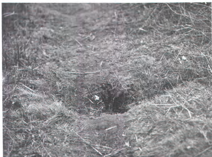
Fig. 3. Verzakking in een landpad, tengevolge van het woelen van een bisamrat.
