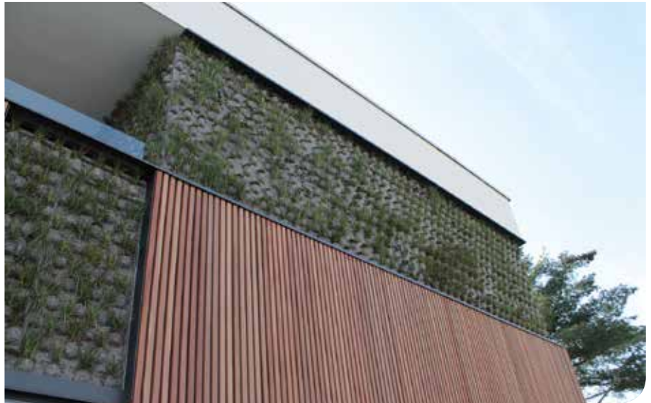
De groene wand is een 'Living Wall System' waarbij de planten verticaal zijn aangeplant in een opbouw met geo-textieldoeken.
