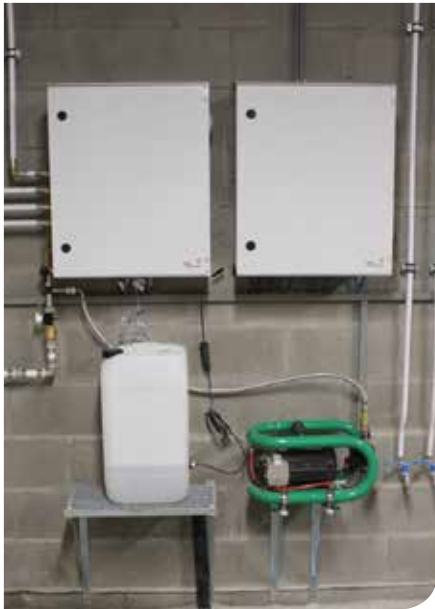
Technische ruimte irrigatiesysteem: hydraulische en elektronische kast, dosering voedingsstoffen en compressor voor het leegblazen van de leidingen.
