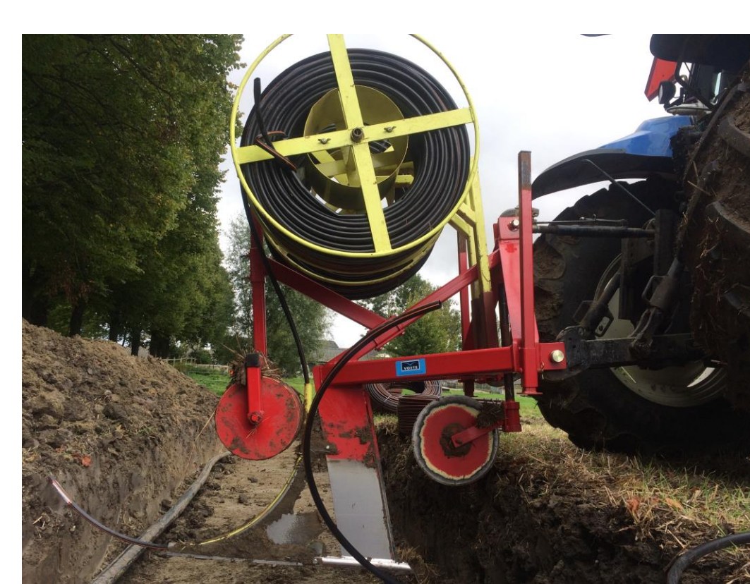
Links: verliestermen die voorkomen kunnen worden met druppelirrigatie. Rechts: aanleg druppelirrigatie in combinatie met mol drainage in Borgsweer.
