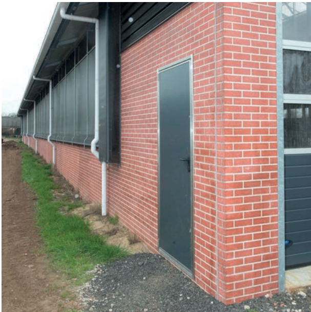
1 Elke hoek in de nieuwe stal heeft een deur
