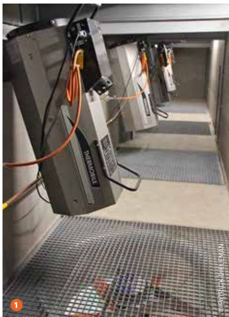
1 In de drukgang voor de uienbewaring zijn de gaskachels standaard opgesteld. Bemerkt de EC-ventilator van 1 meter diameter. Ook de muur tussen drukgang en bewaring werd uitgevoerd in beton. 2 De luchtinlaat werd achteraan onder de dakoversteek voorzien. Daar bevindt zich ook de trap naar de drukgang.
