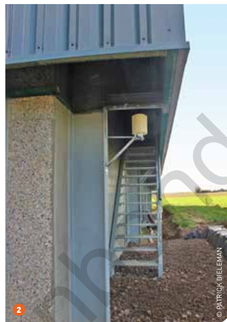
1 In de drukgang voor de uienbewaring zijn de gaskachels standaard opgesteld. Bemerkt de EC-ventilator van 1 meter diameter. Ook de muur tussen drukgang en bewaring werd uitgevoerd in beton. 2 De luchtinlaat werd achteraan onder de dakoversteek voorzien. Daar bevindt zich ook de trap naar de drukgang.
