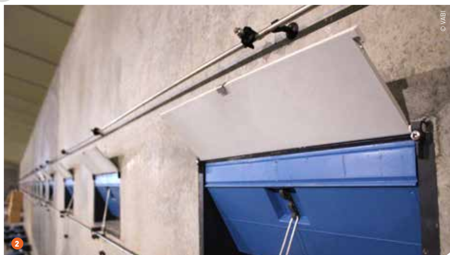
1 Pluimveehouder Jan Lisabeth voor de ingang van een van de stallen. 2 Net boven het inlaatventiel is er een extra geleidingsplaat gemonteerd. Bemerkt bovenaan ook de vernevelingsinstallatie om op warme dagen te koelen.
