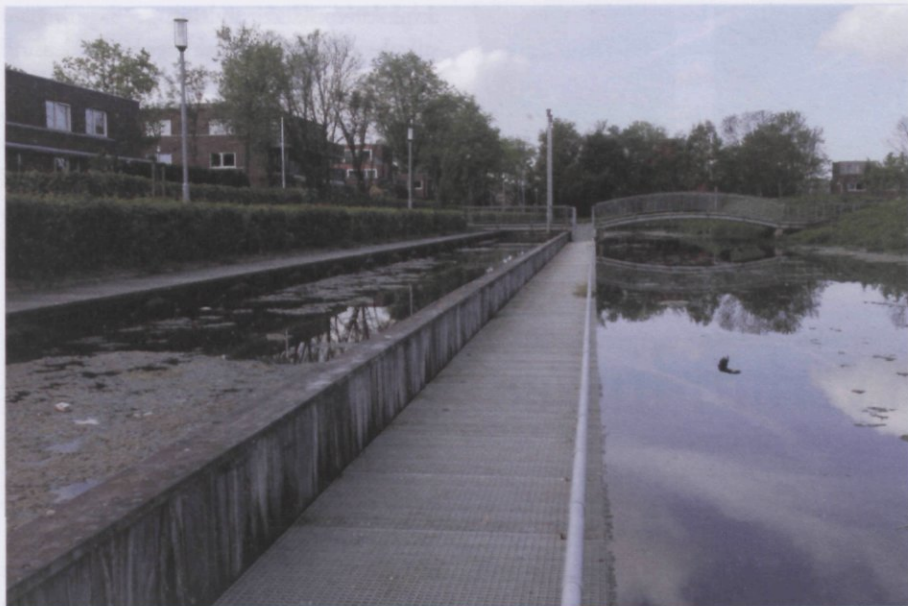
Infiltratiegoot in Egelshoek (foto: Marcel Rob).
