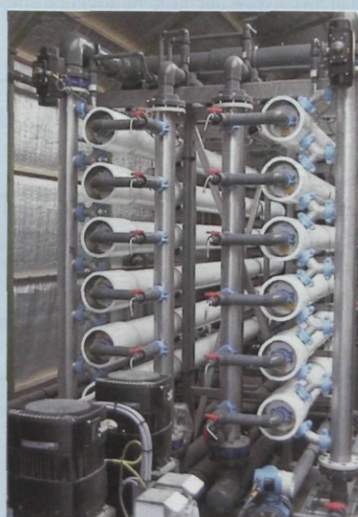
Fig. 3: CAPFIL effluent polishing application: (a) membrane module, (b) communal WWTP effluent.
