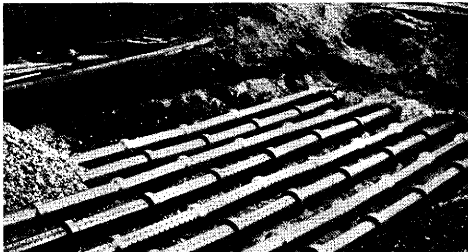
Afb. 6 - Drukkamerfilter.
