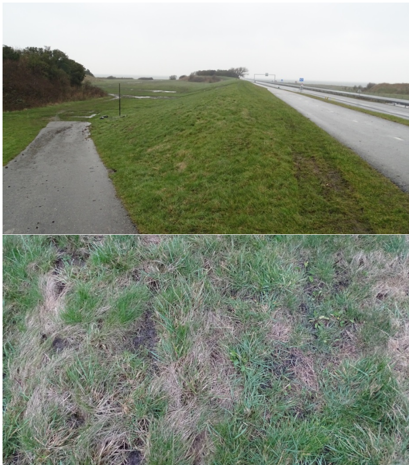
Foto 24: Overzicht en detail proefvak 20, met cross sporen
