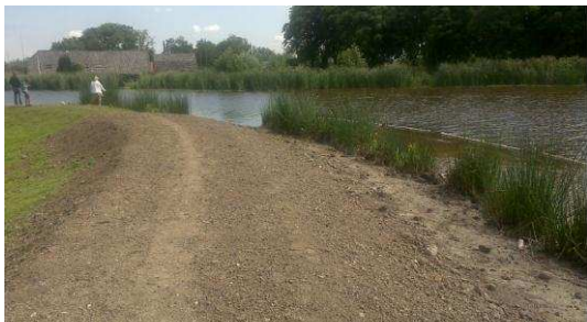
Aanleg van natuurvriendelijke oever bij kadewerk
