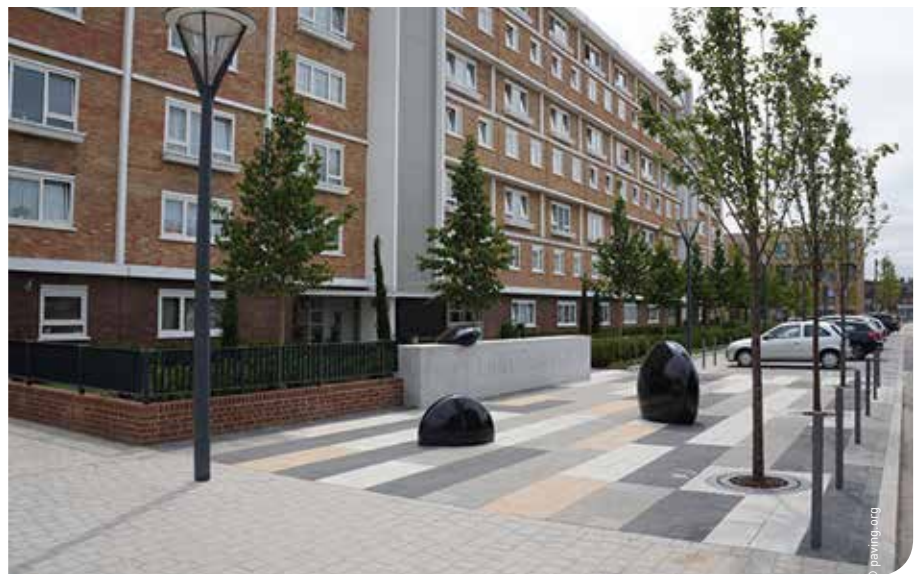
Waterdoordringbare verhardingen in ontwikkeling. De eerste fase van het Brownfield Estate in Londen E14 maakt intensief gebruik van kleurvolle doordringbare betontegels.
