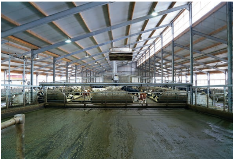
Ludo van Haeren uit Wehl (GD) koos voor een Italiaanse stal met een dakhelling van nog geen 30 graden en twee zij-inlaten in het dak op het noorden. Daarmee bespaart hij op de kosten ten opzichte van een traditionele stal.
