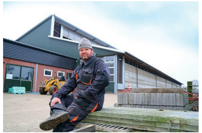
Ludo van Haeren uit Wehl (GD) koos voor een Italiaanse stal met een dakhelling van nog geen 30 graden en twee zij-inlaten in het dak op het noorden. Daarmee bespaart hij op de kosten ten opzichte van een traditionele stal.
