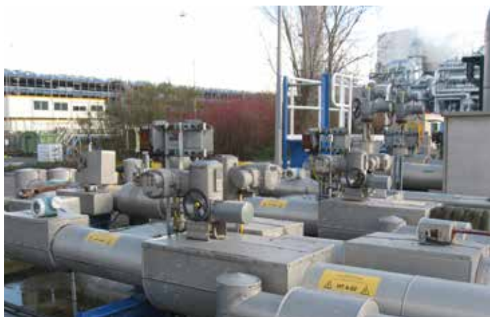
Bestaande installatie voor afvalwaterzuivering op het Huntsman-terrein. (foto: Evides Industriewater/Huntsman)
