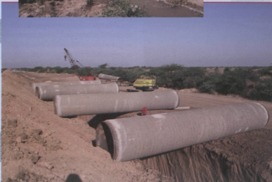
Een 700 kilometer lange pijpleiding brengt water uit een stuwmeer naar woestijngebieden in het westen van India, die hiermee geïrrigeerd kunnen worden.
