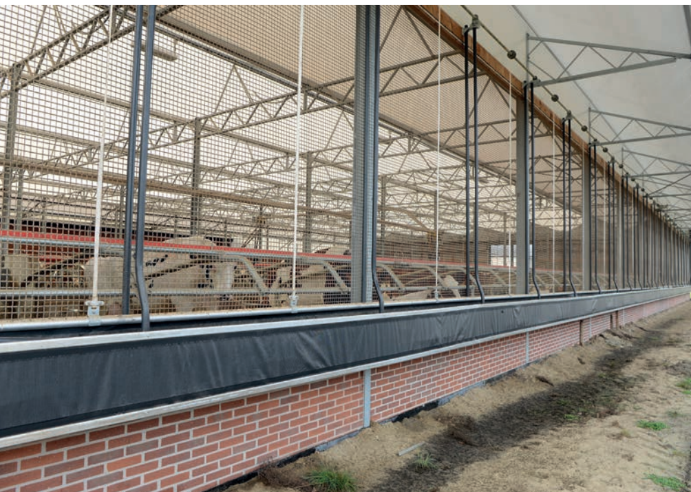
Serrestal voorziet in extra veel licht- en luchtinlaat
