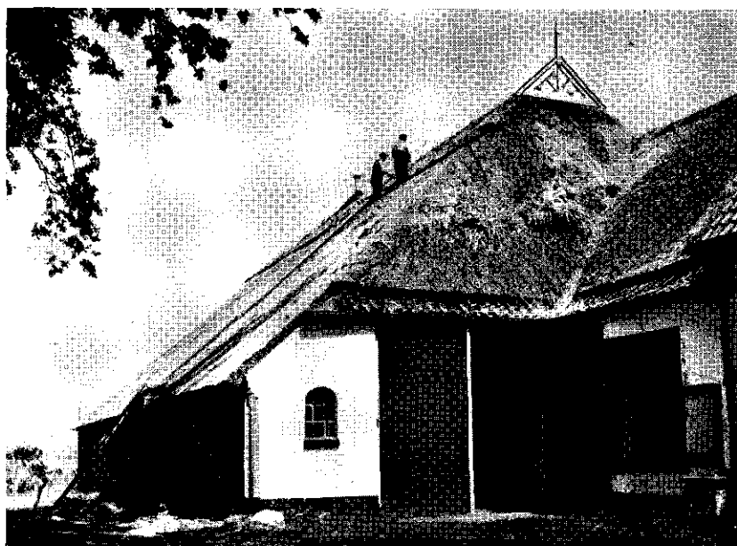
Afb. 1. Vernieuwing van een rieten dak is een kostbare zaak.
