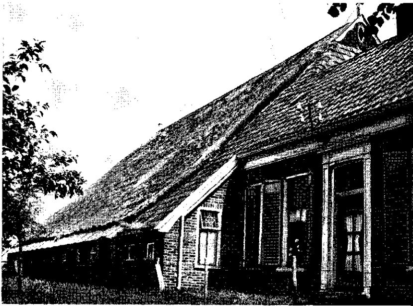
Afb. 2. Boerderij met een rieten dak dat aan grootonderhoud toe is.
