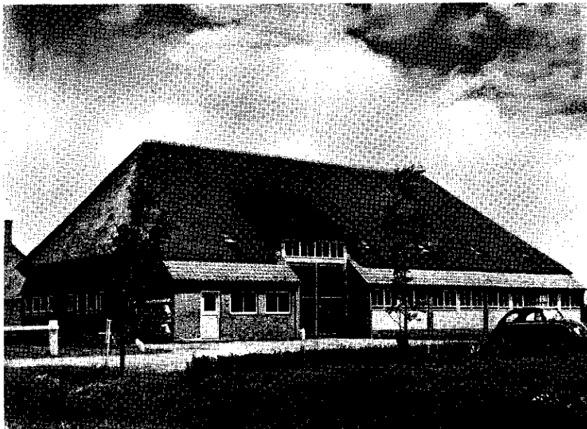
Afb. 8. Een gaaf rieten dak op een nieuwe boerderij. In het dak zijn een aantal asbest-cement buizen aangebracht voor de ontluchting van de stal en de schuur. De doorsnede van de buizen bedraagt 20 cm.
