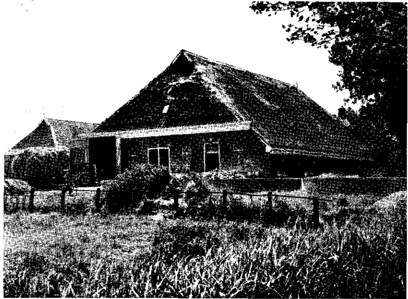
Afb. 13. Boerderij met een versleten rieten dak.
