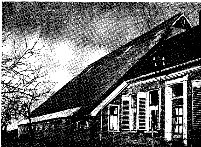
Afb. 3. Dezelfde boerderij als in afb. 2; op het riet zijn asbestcement golfplaten aangebracht. In de tweede rij platen van boven zijn ventilatieplaten opgenomen. De onderste rij platen zijn plastic glasvezel golfplaten ten behoeve van de verlichting van de stal.
