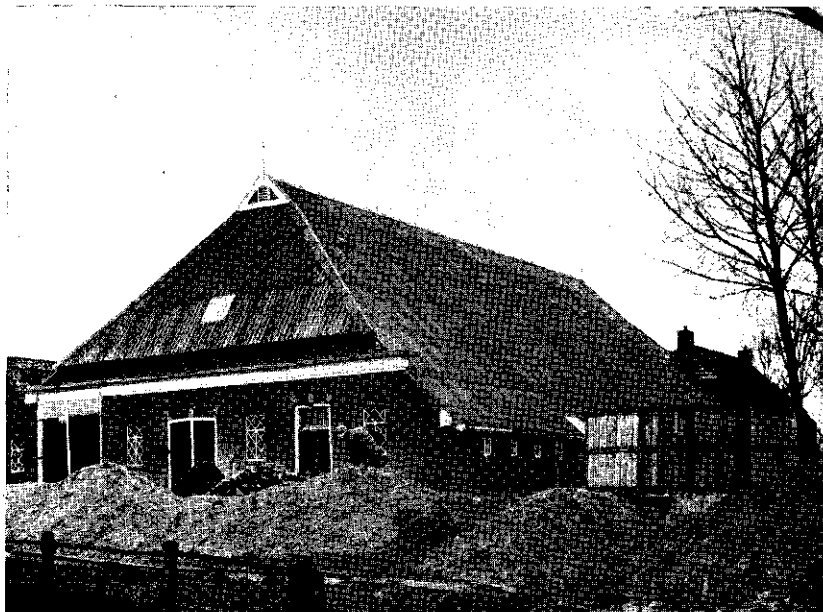
Afb. 14. Dezelfde boerderij als in afb. 12; op het riet zijn asbestcement golfplaten aangebracht.
