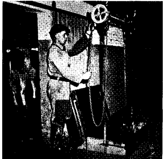
AFB. 16. Luchtrail met ophijsbare bak. Bij dit systeem kost het opschuiven van de mest, het ophijsen van de bak en het stapelen op de vaalt te veel tijd
