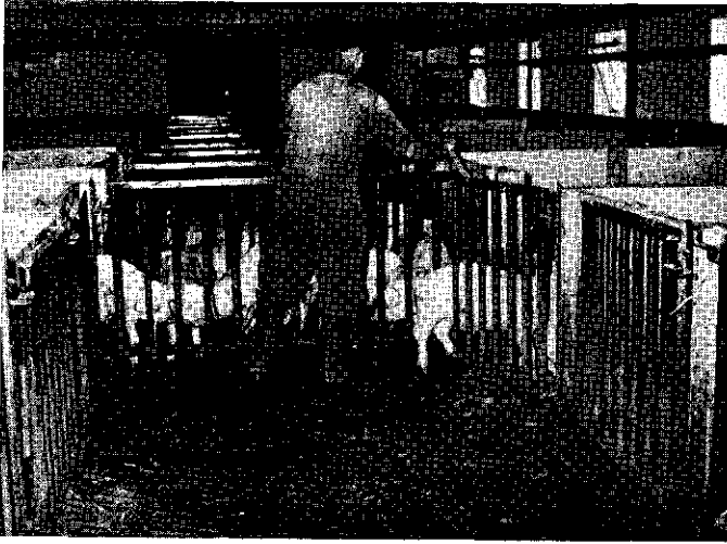
AFB. 28. Gezwaaide dubbelrijige Deense varkensstal. Bij het uitmesten worden de mestgangdeurtjes weggeklapt zodat een mestgang van 2 m breedte vrijkomt
