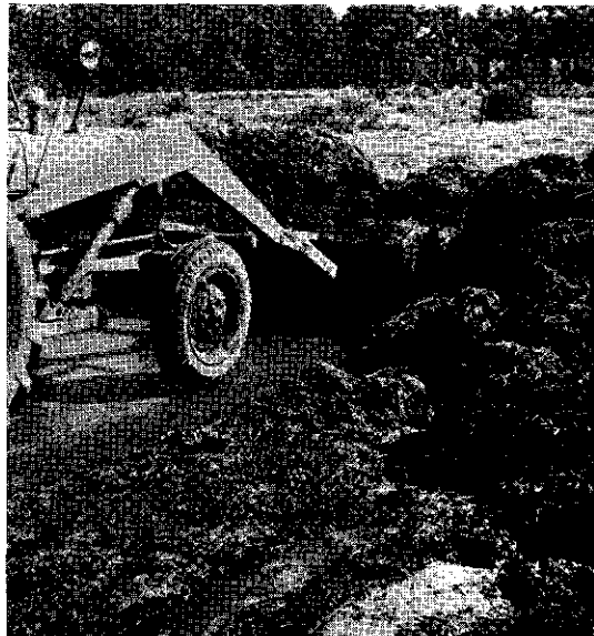
AFB. 29. Opschuifbord aan de hefarmen van de voorlader van de trekker
