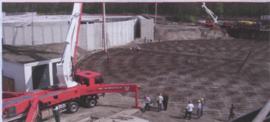
De rwzi Eindhoven tijdens de bouwwerkzaamheden vorig jaar zomer.
