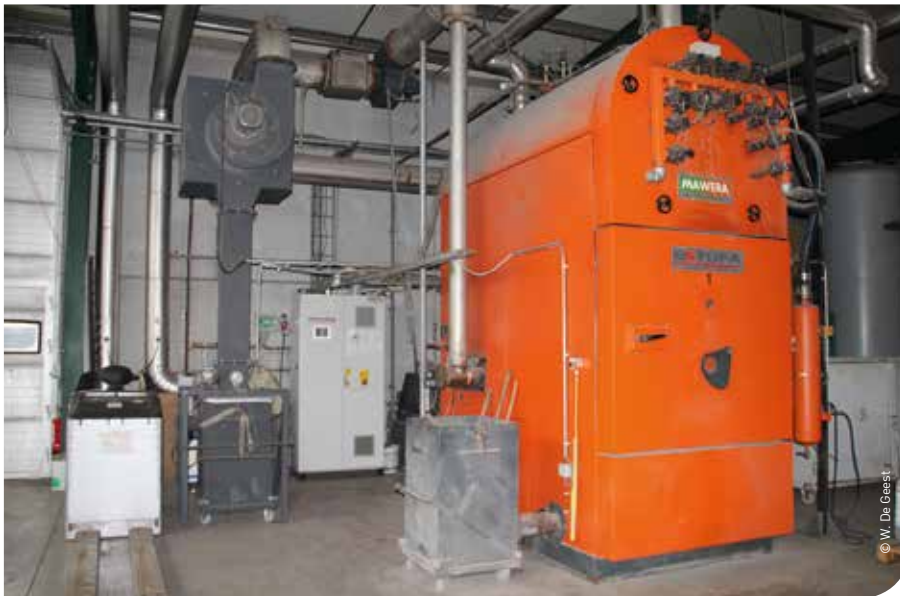
▲ De houtbrander bij Van Eetvelde heeft een capaciteit van 700 KW.
