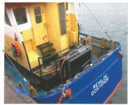
Installatie bakkensysteem op het achterdek van O.190 met schuifkleuren en isolatieclaus
