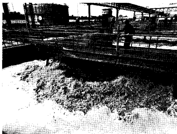
Biologische zuiveringsinstallatie van de Farbwerke Hoechst AG. Oppervlaktebeluchter (type Vortair).
