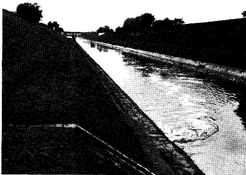
Fig. 1 - De Emscher is een open riool met afvoeren van 10 - 30 m 3 /sec. De BOD 5 van het water bedraagt 140 mg/l.
