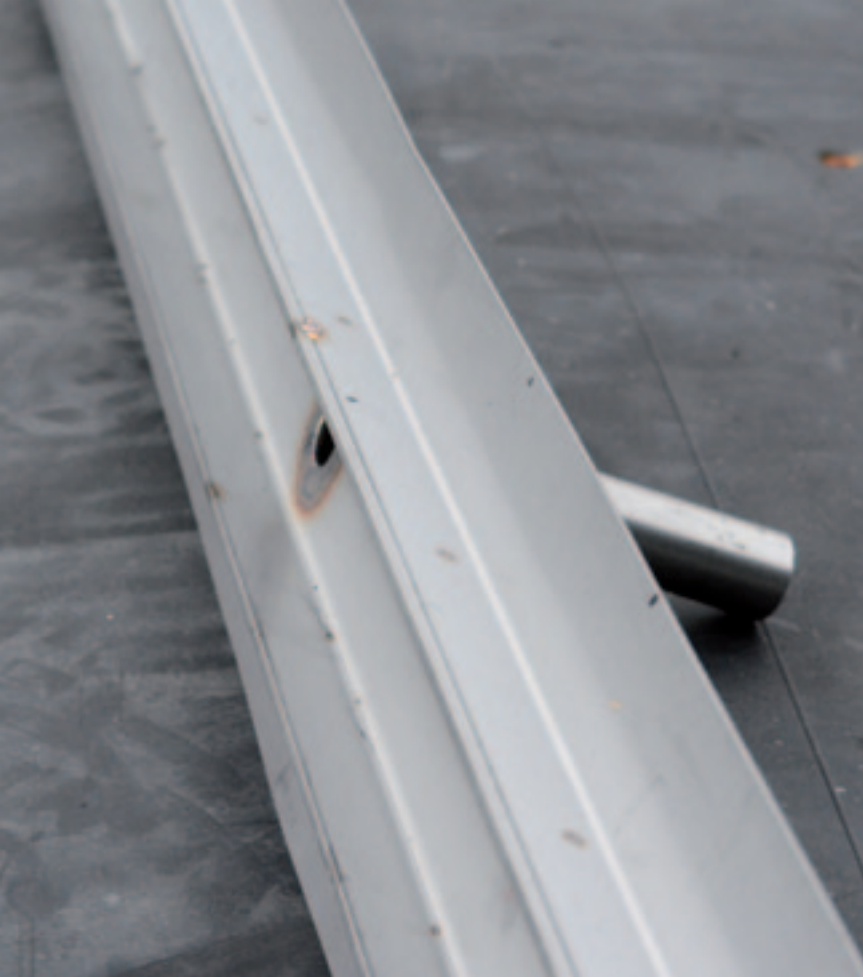
Het centrale U-profiel. Urine kan door het buisje aan de onderkant in de mestkelder of in een andere afvoerbuis, lopen.
