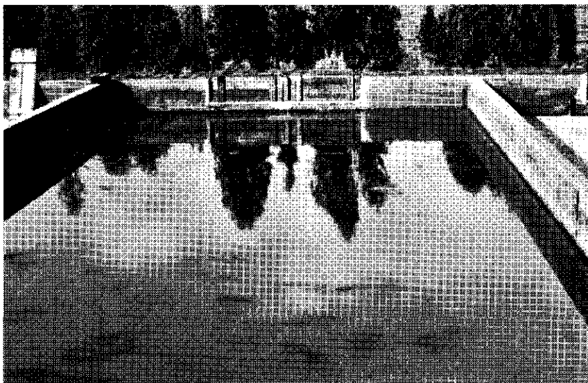
Afb. 8 - Slibbed te Schijndel gevuld met uitgegist slib zonder toevoegingen.
