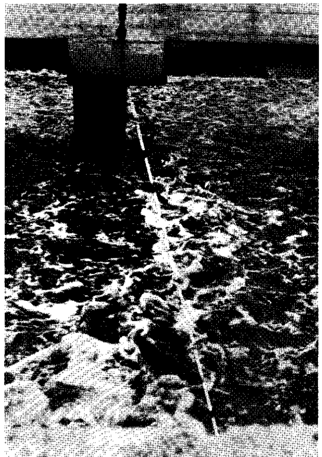
Abb. 18 - Hydraulische Grenzlinie zwischen Kreiselbelüftern.
