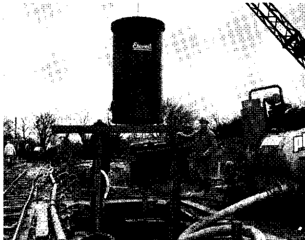
Afb. 7 - Inspectie-schacht van asbestcement.
