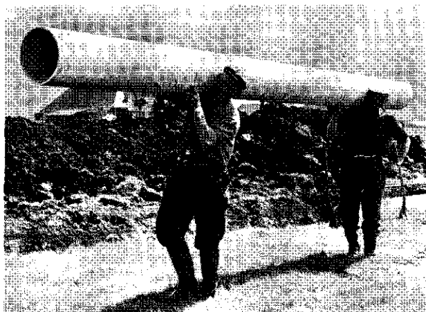
Afb. 8 - Duikerbuis \varnothing 300 mm van 5 m lengte.
