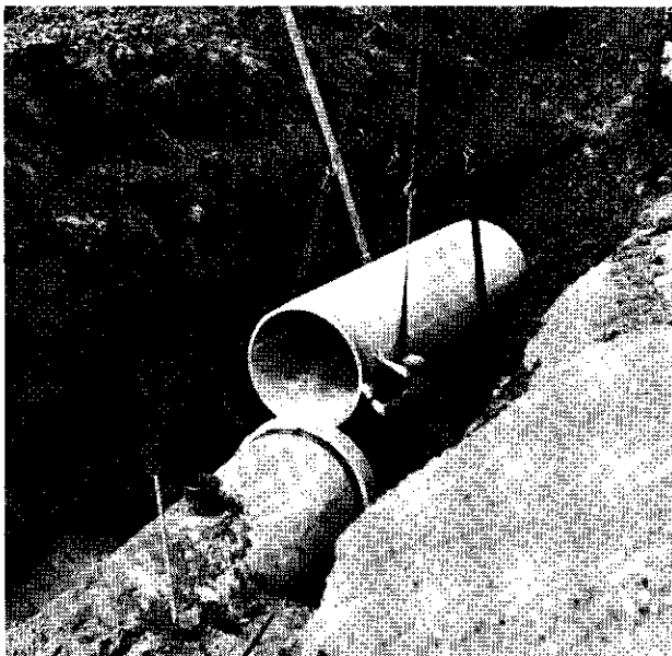
Afb. 1 - Rioolbuizen \varnothing 1200 worden gelegd.
