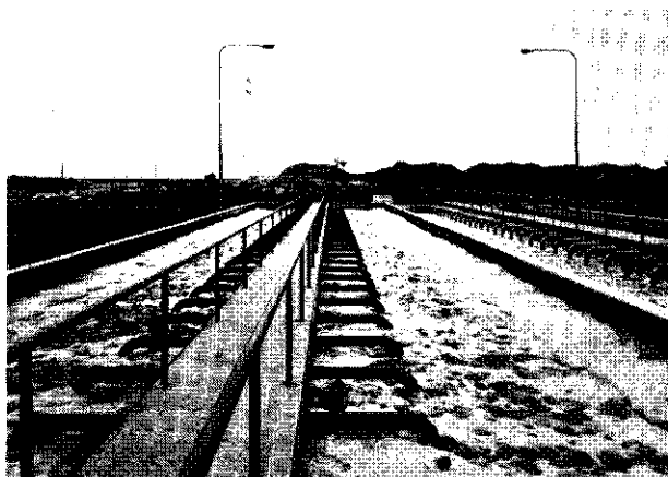
Afb. 8 - Inka-roosters in de actiefslibinstallatie.
