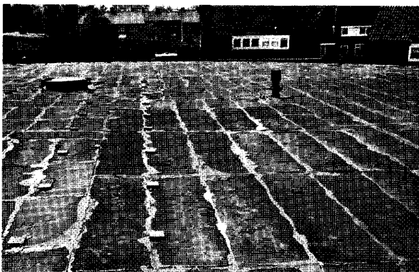
Afb. 8 - Dakisolatie van het reservoir Geldermalsen bestaande uit platen polyurethaanschuim.
